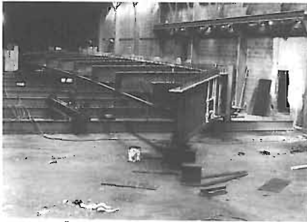
– Gabarit de montage – Demi charpente terminée.
