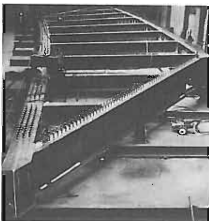
– Montage à blanc de l'ensemble de la charpente.
