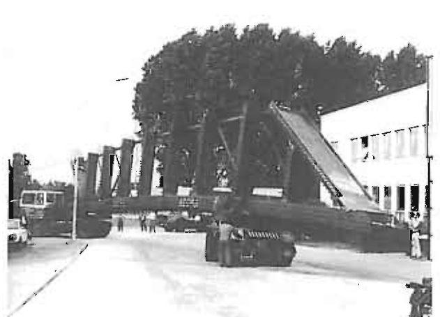
– Transport d'une moitié de charpente.
