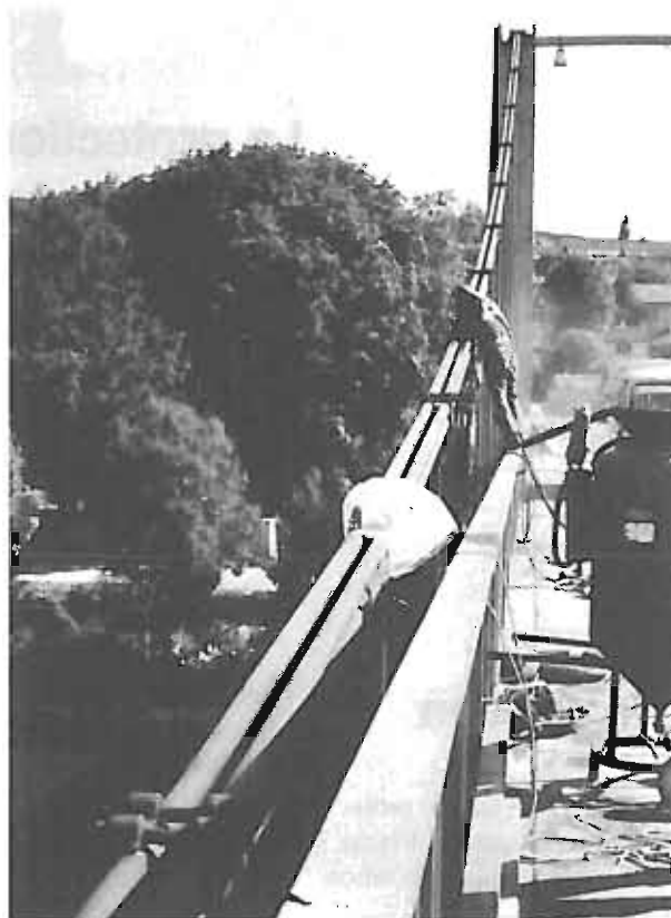
Figure 1 — Décapage sur le site d'un ouvrage avant mise en peinture.
